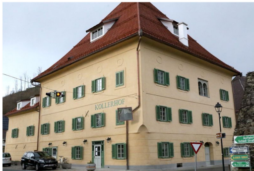
Der Kollerhof ist Teil von Straßburgs erstem "Hochhaus" © Wilfried Gebeneter
